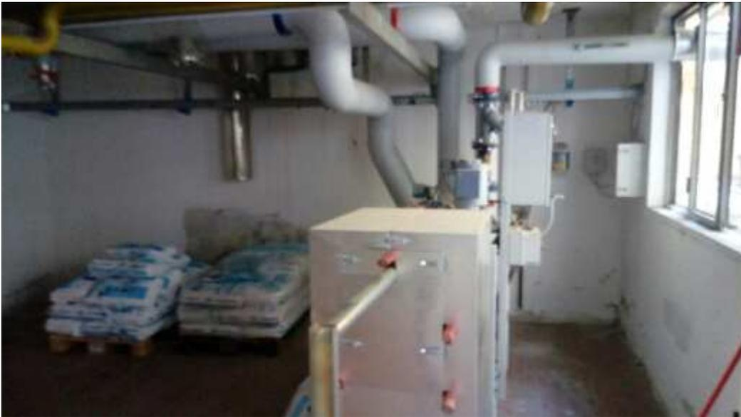
Foto 14 – Scambiatore Teleriscaldamento Via Scalabrini, 19
