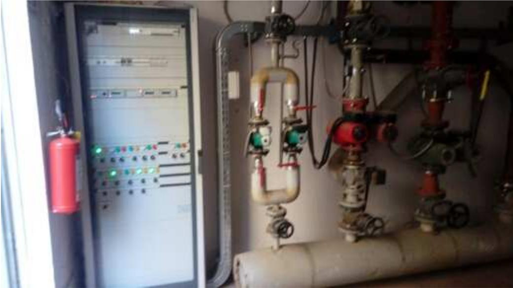
Foto 13 – Scambiatore Teleriscaldamento Via Scalabrini, 19
